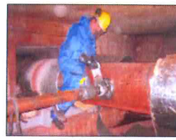
5. Freigabe des Rohr-Abzweiges
