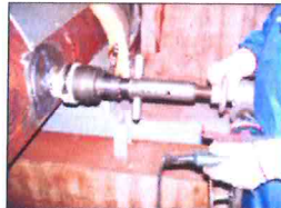
3. Anbohren unter Druck
