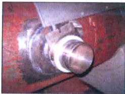
1. Anschweißen der Verschlussvorrichtung
