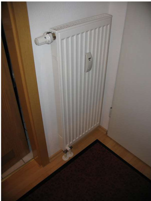
Normanschluss mit VL oben
