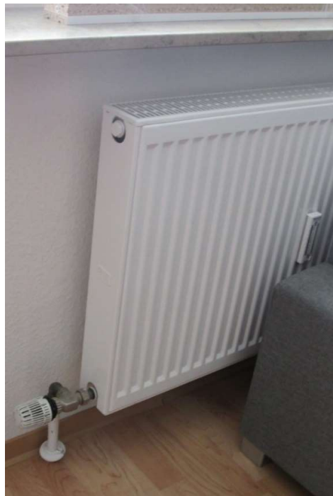
Reitender Anschluss mit VL und RL unten
