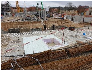
oberflächennahe Geothermie / Kalte Nahwärme
